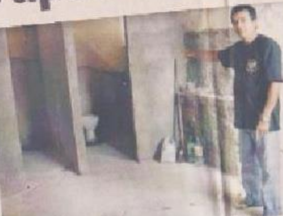
JOSE WILLIAMS , vicepresidente de Isolat, muestra parte del sistema de aislamiento de la cubierta sobre la estructura de acero galvanizado.
