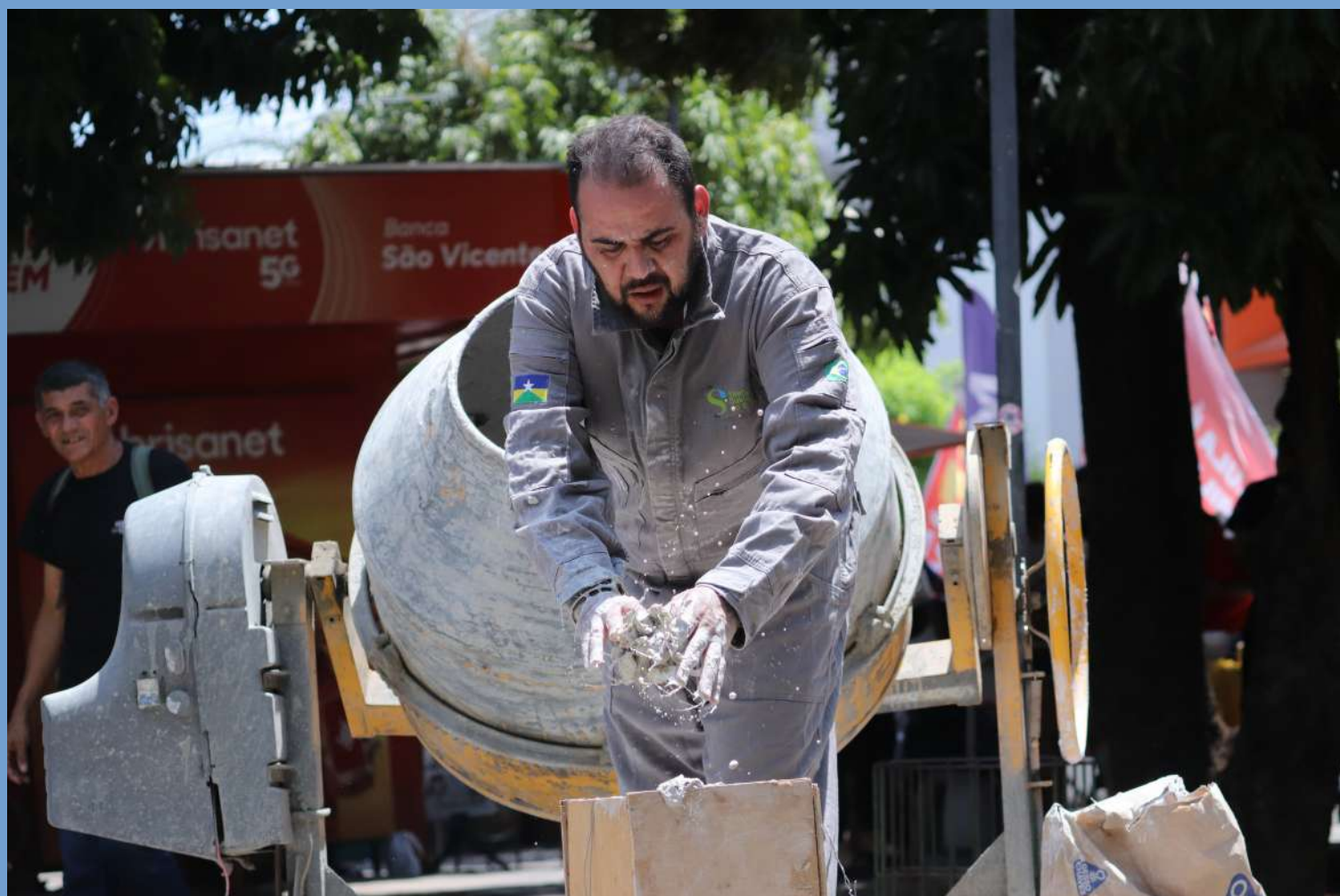
Quem sustenta? Edificações desobedientes de Wander Landim. Foto Rodolfo Santana.
