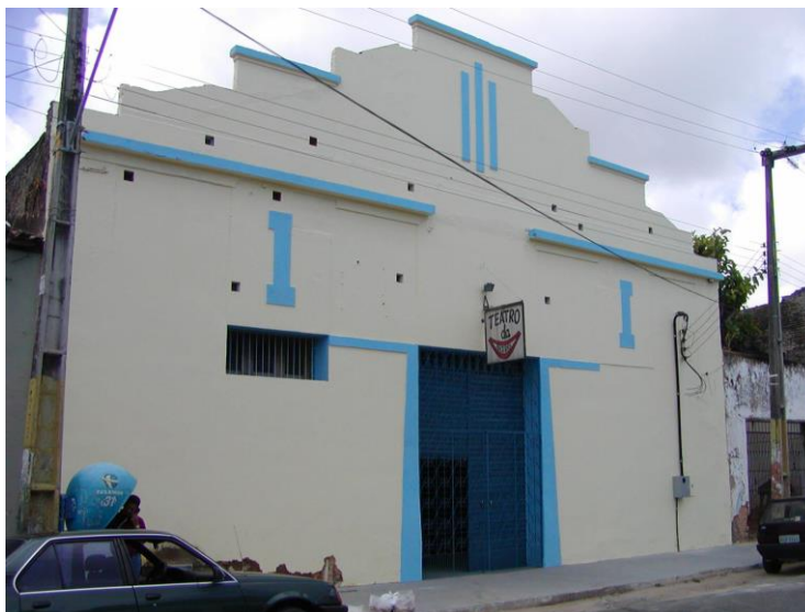
Figura 24 – Fachada do Teatro da Boca Rica - Fortaleza - Ceará
